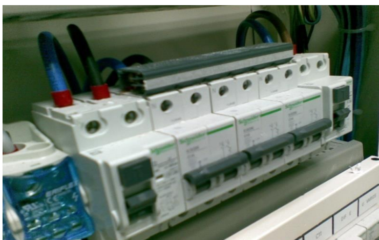
Figura 11 – Conexión de aparamenta mediante peine de distribución
